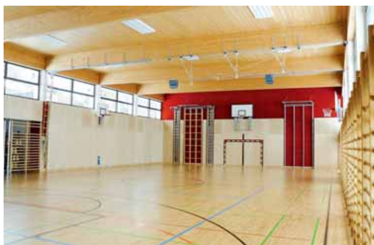
Vor ihrer Fertigstellung steht die Neue Mittelschule in der Gemeinde Wenns.
