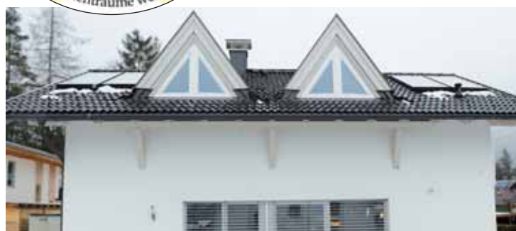
Eine Solaranlage am Dach sorgt für kostenlose Energie.
