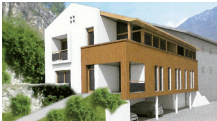
Außenansicht des neuen Pfarrsaales.
