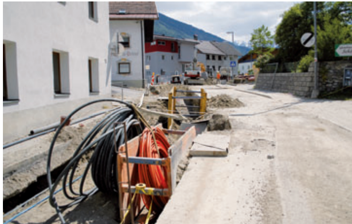
Das Dorfzentrum von Arzl ist derzeit eine einzige Baustelle.
