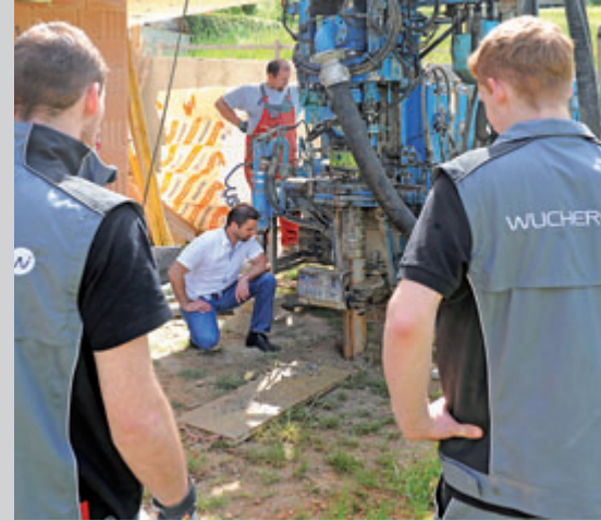
Tiefenwärmebohrungen sind heutzutage rasch zu bewerkstelligen und fördern nachhaltige Energie.
