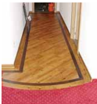
Designboden mit Einlegearbeit, im Anschluss ein Teppichboden.
