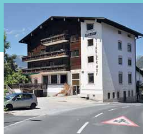
Der Tirolerhof vor dem Umbau.
