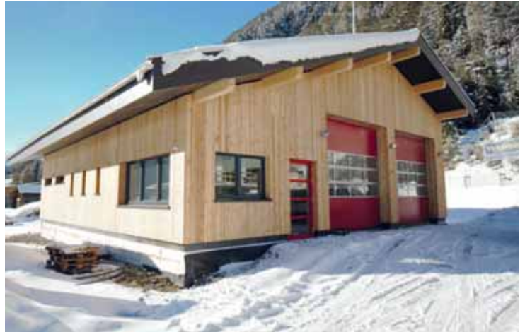
Das neue Feuerwehrhaus in Schnann wird im September seiner Bestimmung übergeben. Foto: Gemeinde Pettneu
