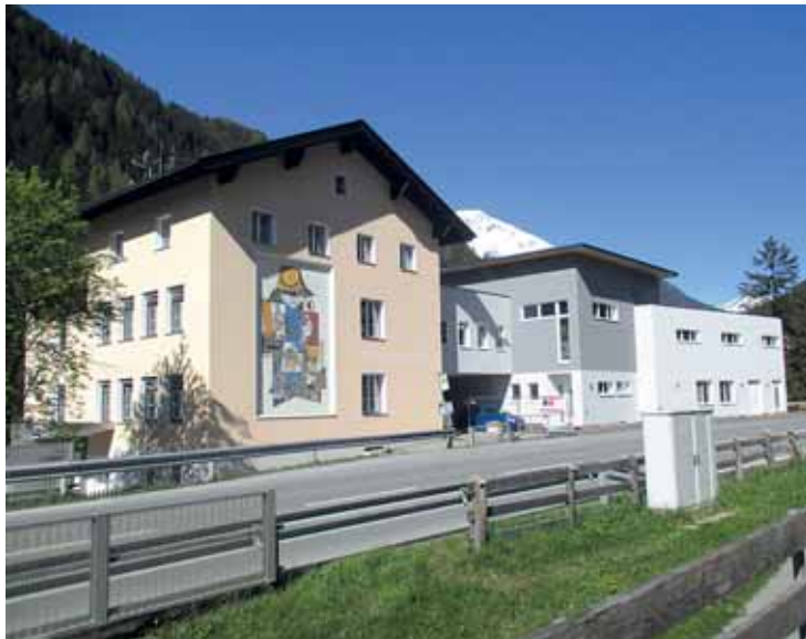
Der Zubau bei der Volksschule schuf in Strengen einen moderneren Kindergarten, einen Turnsaal und ein Probelokal für die Musikkapelle.
