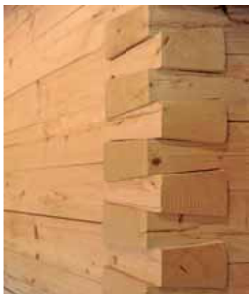
Schwalbenschwanzverbindungen an der Hauswand.
