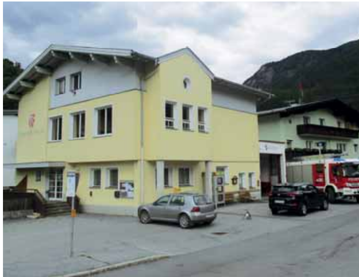
Das Gemeindehaus in Faggen, in dem auch die vor 50 Jahren gegründete Feuerwehr untergebracht ist, soll demnächst saniert werden.
