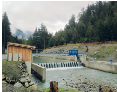
In wenigen Tagen nimmt das neu errichtete Gemeindekraftwerk seinen Vollbetrieb auf. Foto: Gemeinde St. Leonhard
