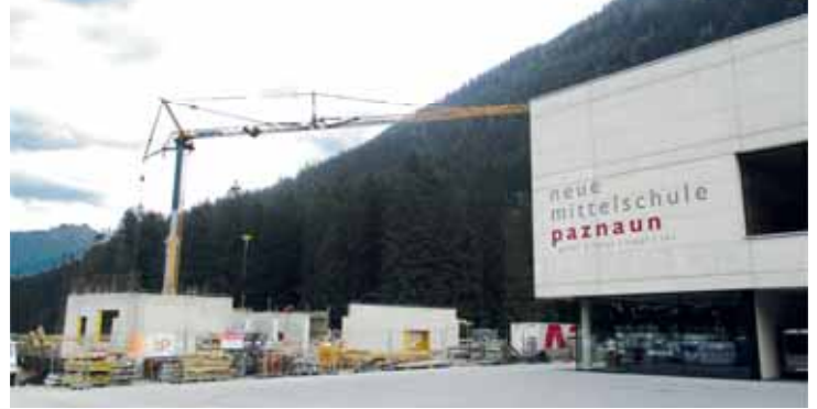
Die neue Volksschule von Kappl erweitert das bestehende Schulzentrum und soll 2017 in Betrieb gehen. Fotos: Eiter
