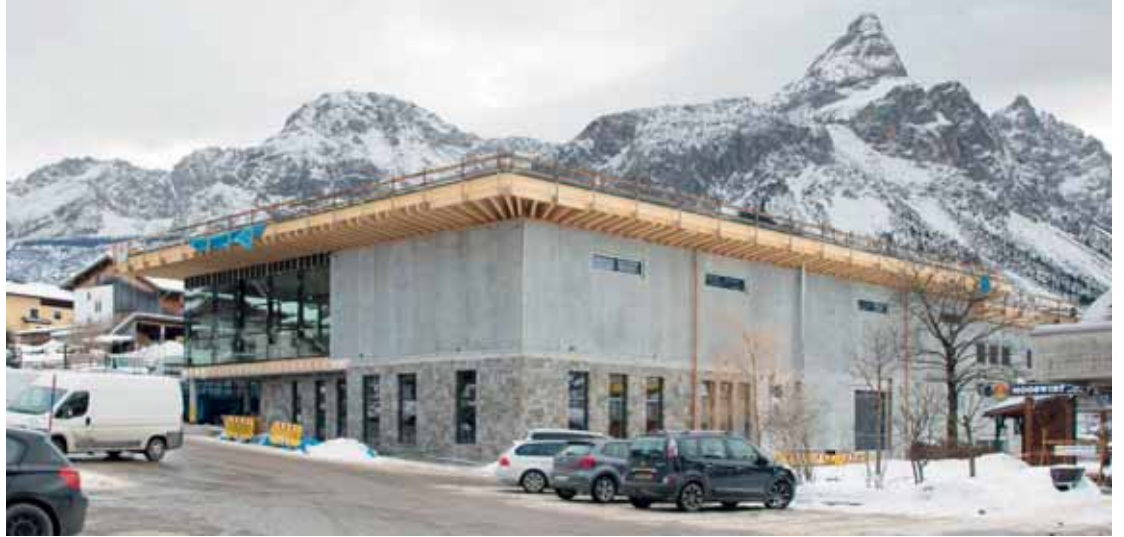
Im Zentrum in unmittelbarer Nähe zum Hallenbad, zur Kletterhalle und zum Zugspitzsaal entsteht das neue Geschäftshaus
