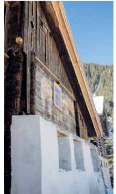
Von außen sieht das Haus nun wieder so aus wie vor ca. 600 Jahren. Nur morsche Holzteile dürfen durch neues Holz ersetzt werden.
