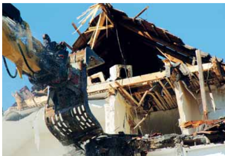
Beim Abbruch von Gebäuden fallen viele unterschiedliche Stoffe an. Die sorgfältige Trennung spart bei der Entsorgung Kosten.
