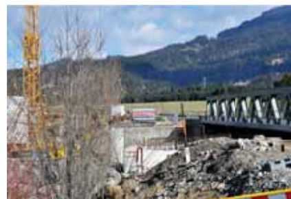
Komplett erneuert wird die Brücke über den Archbach.
