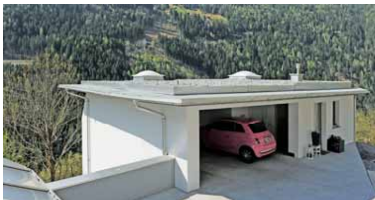
Am Ortseingang des Weilers Eichholz entstand das neue Haus der Familie Schütz. Einer der obersten Gebäudeteile ist die Garage.
