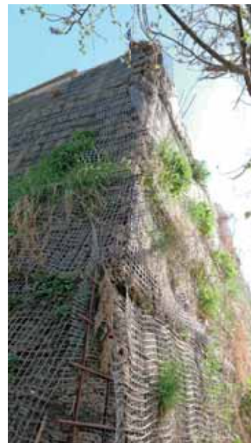
Das System der „Bewehrten Erde“ erlaubte eine Böschungneigung von 80°
