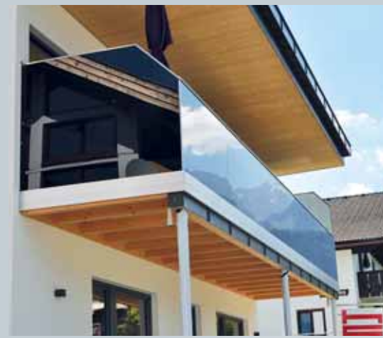
Einen überdachten Balkon zu konstruieren und zu fertigen ist für Martin Kerber ebenfalls kein Problem.
