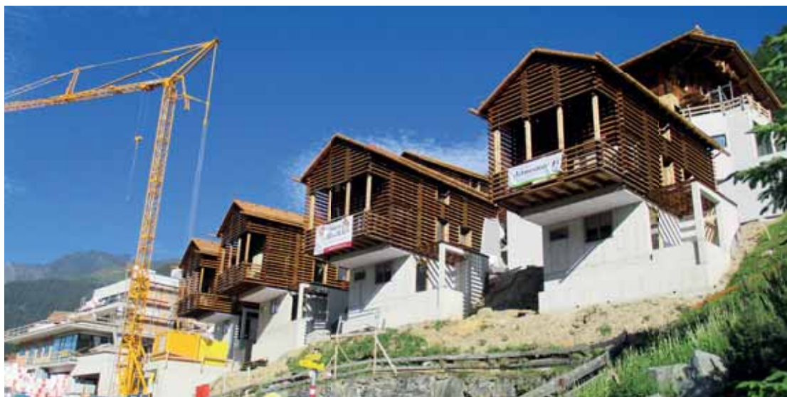
Eine Baustelle, die allen Freude macht: Die Feriensiedlung „Bergwiesenglück“ im Ortsteil Neder in See soll im August in Betrieb gehen.
