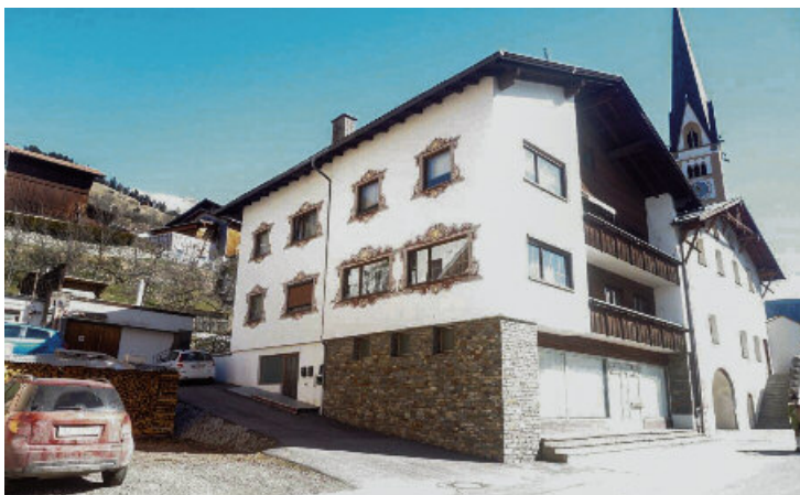
So sah das Haus vor dem Umbau aus.
