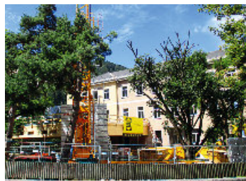
Die Volksschule Angedair ist ein Jahr lang Großbaustelle. Die rund 400 Schüler müssen für die Sanierung ausquartiert werden.
