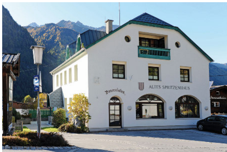
Im alten Spritzenhaus wurde eine neue Kindergartengruppe eingerichtet.
