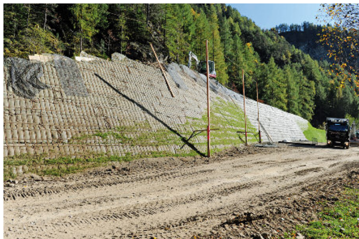
Diese Schutzmauer stellt den ersten Schritt zur Verwirklichung des Naturparkhauses dar.
