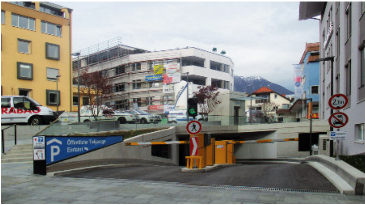
Der Platz oberhalb der Tiefgarage hinter der Sparkasse soll vor Weihnachten fertiggestellt sein. Ein Brunnen und viele Sitzplätze laden zum Verweilen ein.
