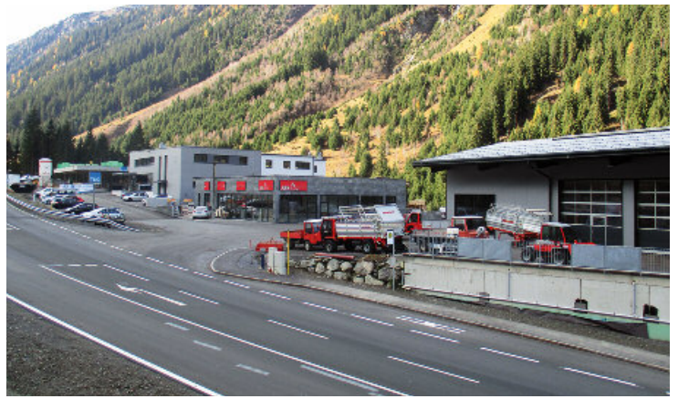
Im neuen Gewerbegebiet von Kappl haben sich sieben heimische Unternehmen angesiedelt. Zirka 40 Beschäftigte finden dort Arbeit. Foto: Eitter
