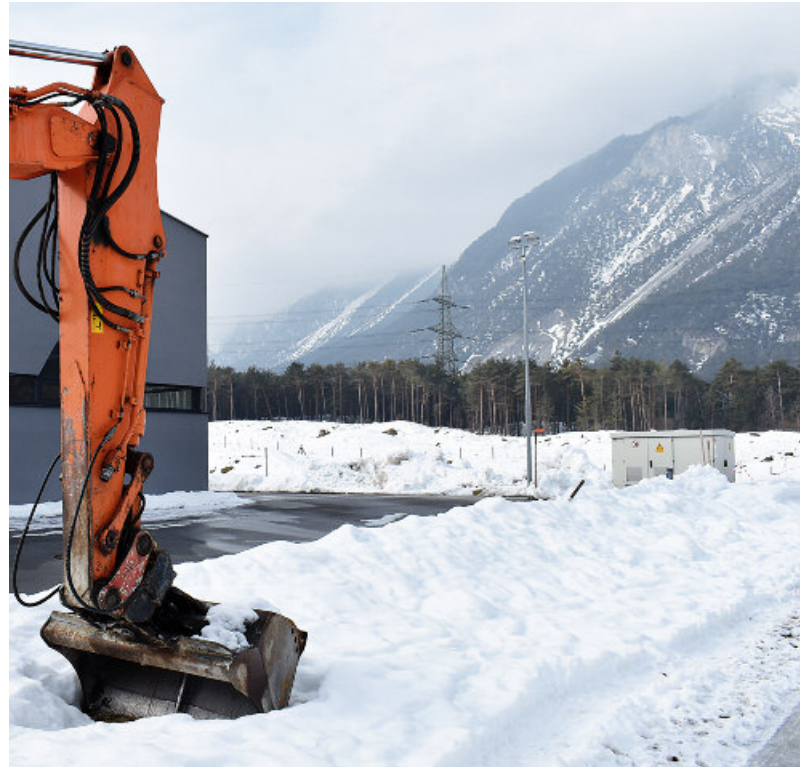
Im Ortsteil Winkling hinter der Feuerwehrrhalle fahren bereits die Baumaschinen auf. Dort entstehen demnächst 32 Einfamilienhäuser. Foto: Eiter
