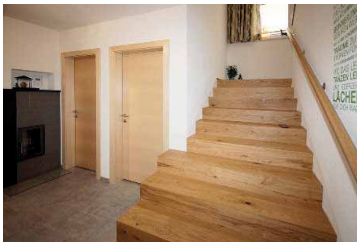
Eine mit Eichenparkett verkleidete Betonstiege führt in die Ruheräume.
