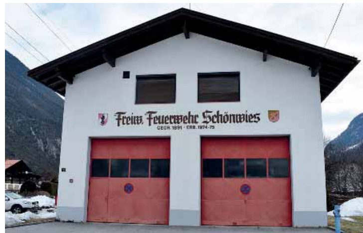
Die Feuerwehrrhalle von Schönwies entspricht längst nicht mehr den modernen Anforderungen. Die Suche nach einem neuen Standort gestaltet sich schwierig. Bürgermeister Wilfried Fink bereitet das Hochwasserszenario Kopfzerbrechen: „Wir sind die Dachrinne des Bezirkes Landeck!“ Fotos: Eitter
