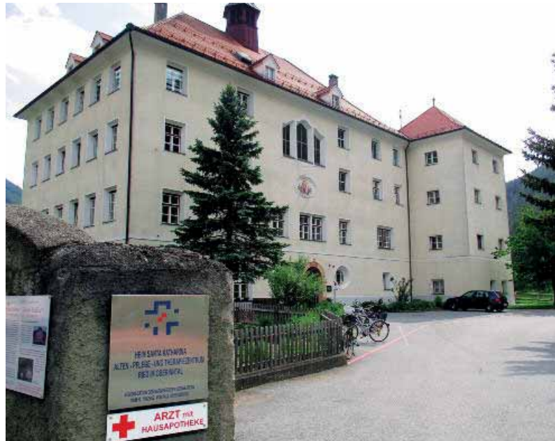
Das Heim Santa Katharina dient bereits seit dem Jahr 1863 der Betreuung pflegebedürftiger Menschen und wird heute als moderner Wirtschaftsbetrieb mit über 100 Mitarbeitern geführt.
