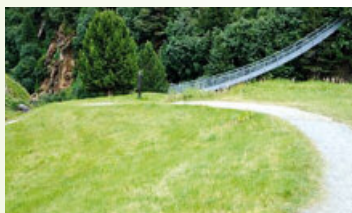
Der Wanderweg von Vent über die Hängebrücke führt direkt zum Rofenhof.
