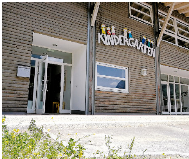
Die Volksschule und der Kindergarten wurden baulich erweitert und verfügen seit diesem Schuljahr über neue Gruppenräume.
