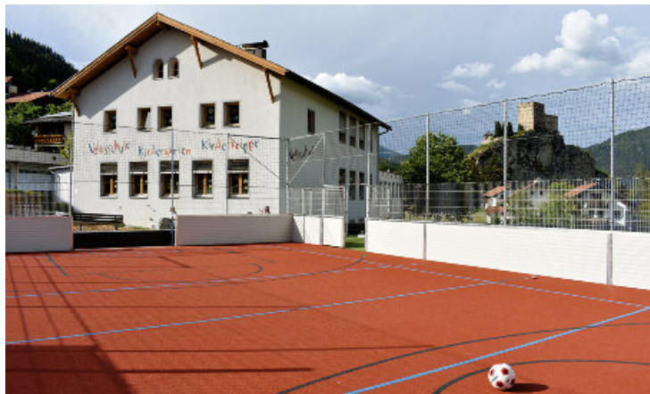
Am Dach der neuen Tiefgarage am Ortseingang von Ladis können Kinder neuerdings auch Ball spielen.
