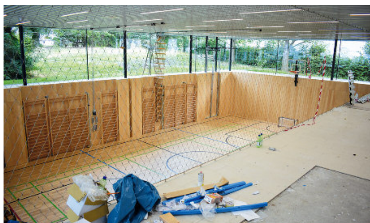
In den Ferien noch Baustelle. Zum Schulbeginn alles picobello fertig. Die Baufirmen haben bei der Schulsanierung perfektes Timing an den Tag gelegt. Foto: Eiter
