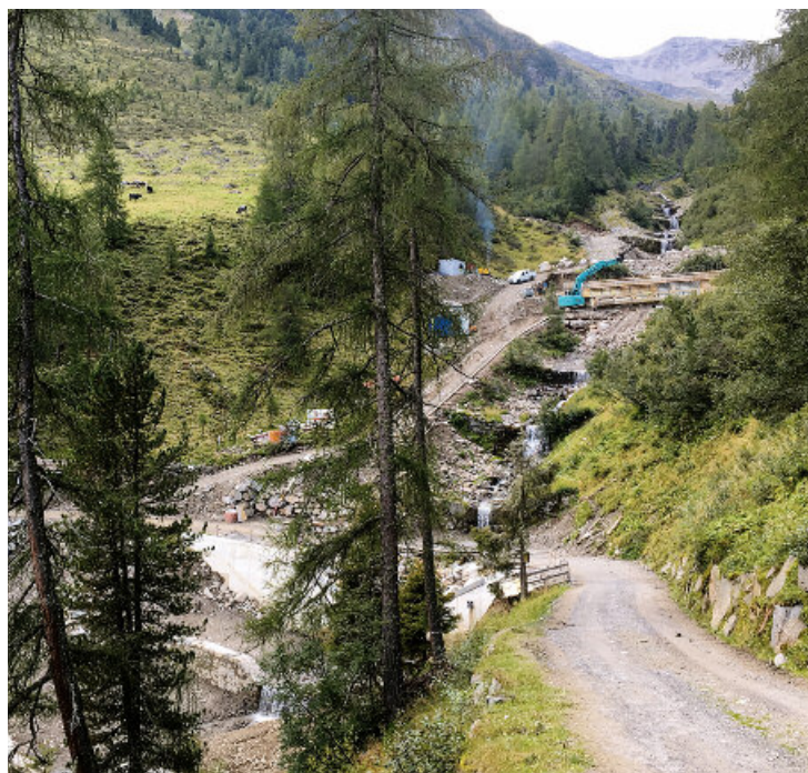
Die Teams der Wildbach- und Lawinerverbauung arbeiten derzeit an der Erneuerung der Geschiebestufen im obersten Bereich.
