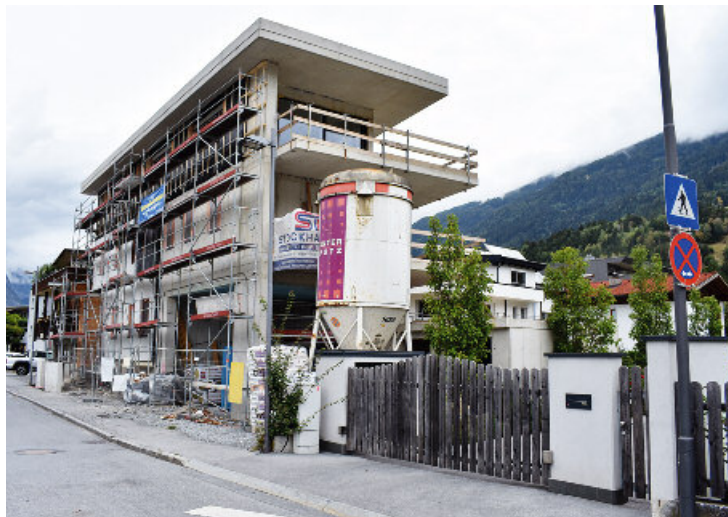
Trotz beschränkter Flächen wird in Landeck – wie hier im Stadtteil Öd – viel gebaut. Die Bezirksmetropole wird demnächst bei der Einwohnerzahl die 8.000er-Marke knacken. Foto: Eiter
