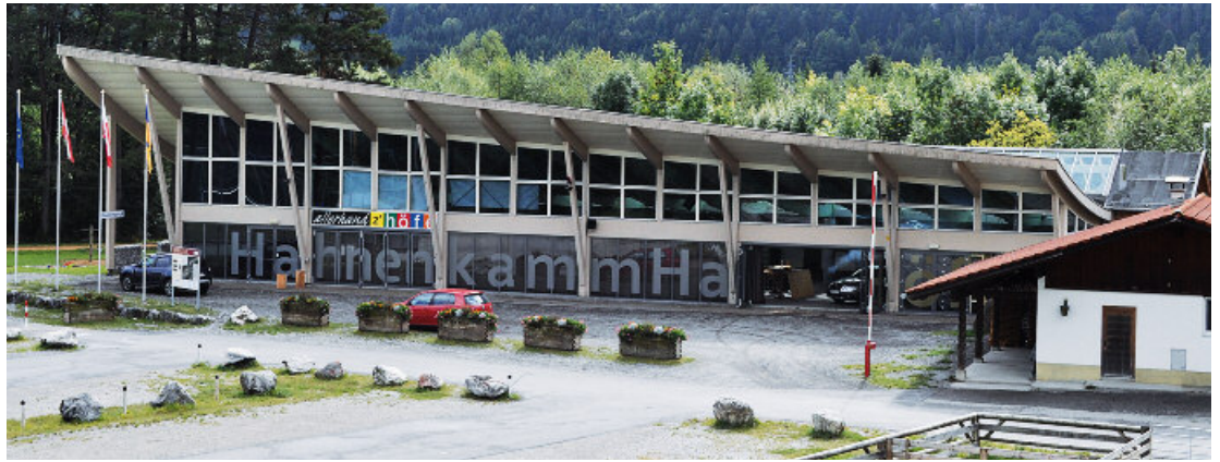
Die in die Jahre gekommene Hahnenkammhalle benötigt dringend ein Facelifting.
