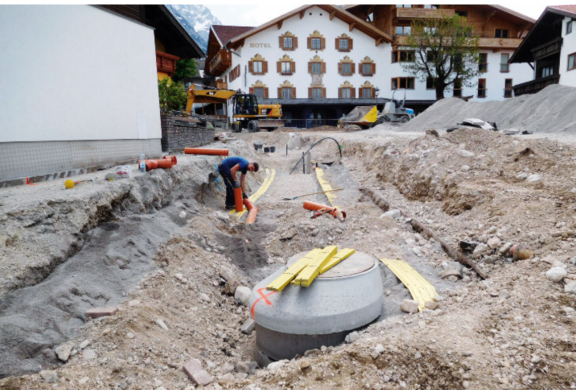
Die Landesstraße durch Ehrwald präsentierte sich heuer als Großbaustelle.
