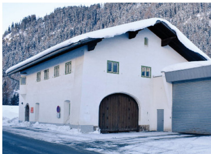
Der Landesbauhof wird in Nauders vom Dorf ins Gewerbegebiet übersiedelt. Rund um das alte Gebäude sollen im Ortsteil Sandbichl 20 Baugründe für junge Familien parzelliert werden.
