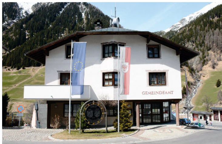
Das alte Gemeindehaus, in dem sich auch sechs Mietwohnungen befinden, wird thermisch saniert und barrierefrei gestaltet. In diesem Zug wird auch der Kindergarten erweitert.
