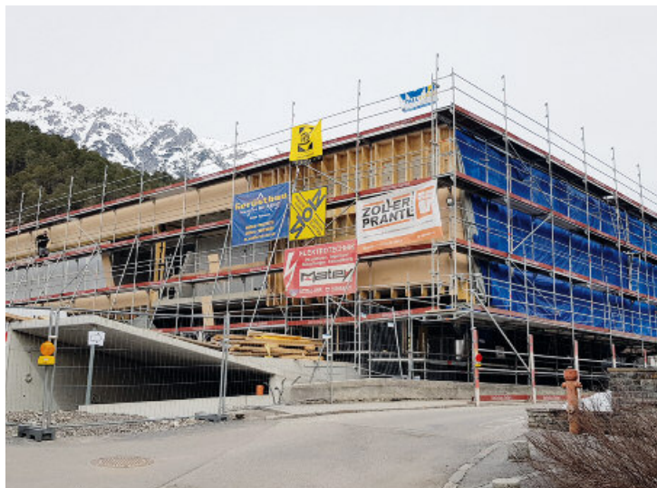
Nach der Fertigstellung der Fassade erfolgt der Innenausbau. Anfang September soll das neue Gebäude schon seiner Bestimmung übergeben werden.
