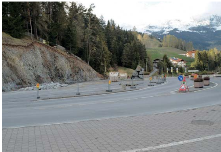
Noch sieht man der Ortseinfahrt von Serfaus das Großprojekt nicht an. Hier soll ein Highlight des Ortes entstehen. Rund 1,5 Millionen Euro lässt sich die Gemeinde ihre neue „Visitenkarte“ kosten.
