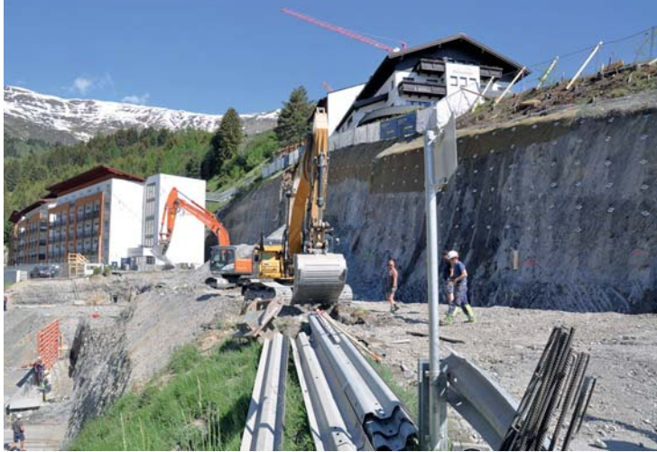
Hier entsteht in Fiss durch die Neue Heimat das vierte Mitarbeiterhaus, das 60 neue Wohneinheiten beinhalten wird.
