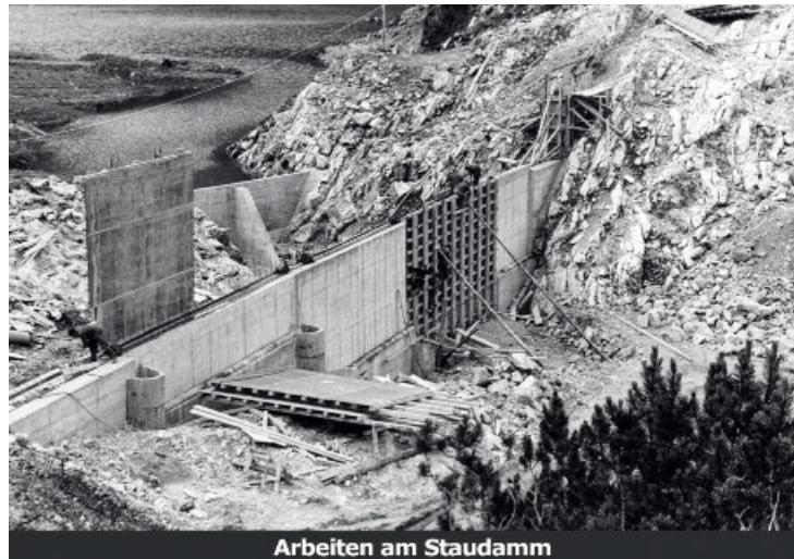
Arbeiten am Staudamm
