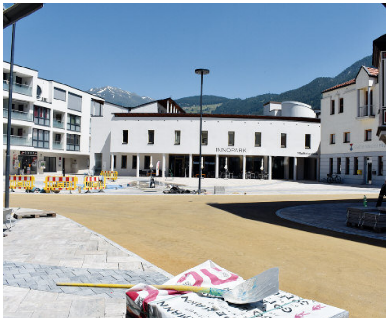
Das Dorfzentrum von Prutz war zuletzt gut ein halbes Jahr lang eine Großbaustelle. Ab sofort gibt es dort eine Begegnungszone.
