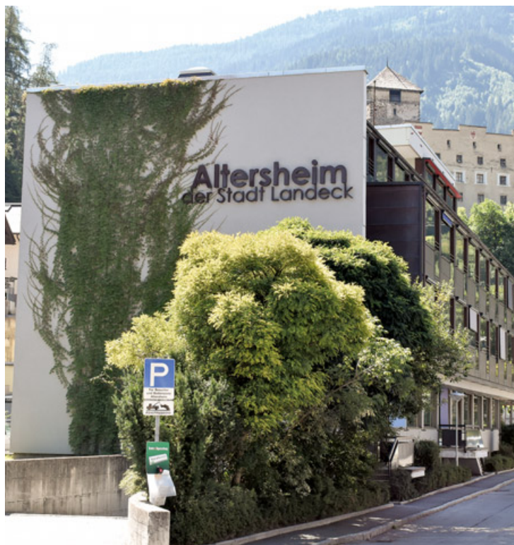
Das einst moderne Gebäude des Landecker Altersheimes ist auch in die Jahre gekommen. Neben der Sanierung steht jetzt auch eine dringend notwendige Erweiterung der Kapazitäten an.
