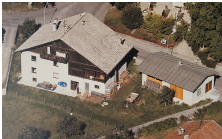
So sah das elterliche Anwesen vor dem Umbau aus.
