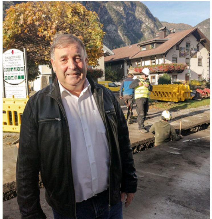
Bgm. Herbert Kröll zeigt sich mit Fortschritt am Bau der Gasleitungen zufrieden.
