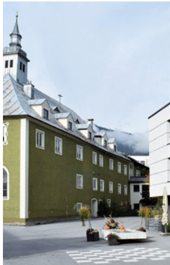
Modernes und Altes sensibel zusammenführen. Das ist die Herausforderung bei der Adaptierung des Imster Klösterles für die Erweiterung des Alten- und Pflegezentrums. Foto: Eiter
