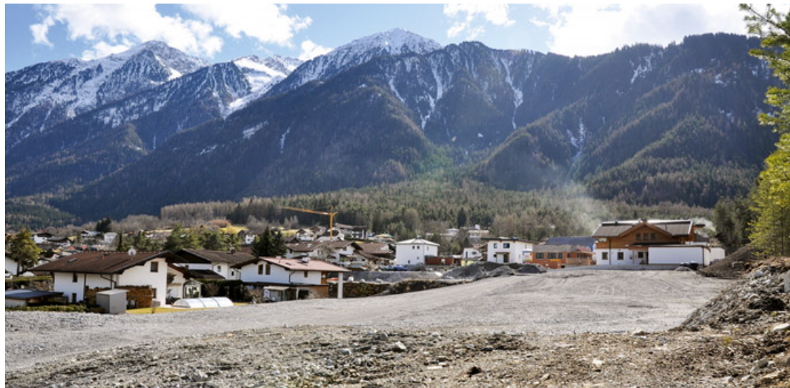
Die zweite Bauphase im Unterreitle sollte heuer starten.
