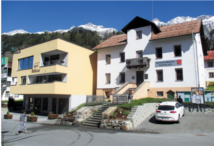
Das Gemeindehaus in Pettneu ist mit 110 Jahren die älteste Amtsstube des Bezirkes Landeck. Das Gebäude wird jetzt für betreubares Wohnen adaptiert.
