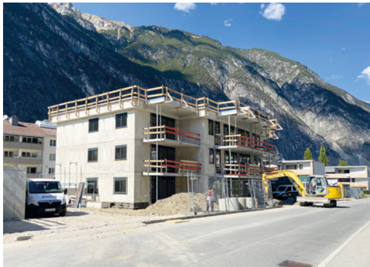
In der Innstraße wird im Moment der sechste Bauabschnitt der Erneuerung der ehemaligen Südtirolerhäuser durchgeführt. Es entstehen 36 neue Wohnungen.
