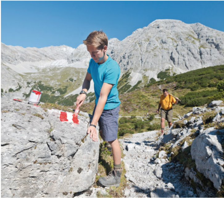
Wegsanierung auf der Nordkette bei Innsbruck.
