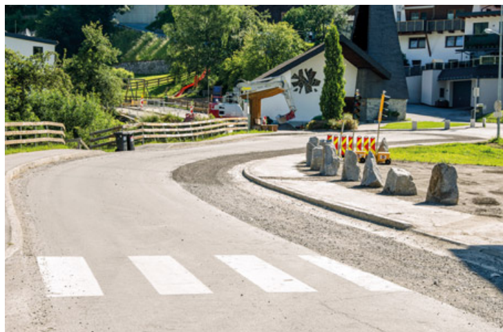
Faggen ist derzeit mit zahlreichen Bauvorhaben beschäftigt.
