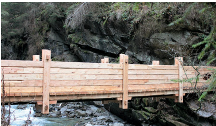
Nach altem Vorbild wurde die Zangenbrücke Kitzgarten neu errichtet.
