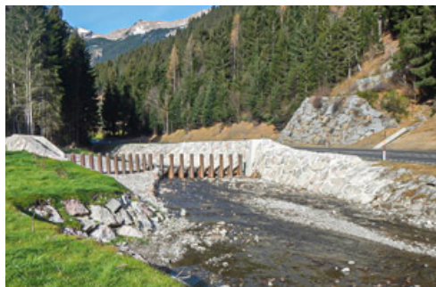
Die Wildholzrechen im Duftlbach (links) und Riegelbach (rechts) sind seit August fertiggestellt.
