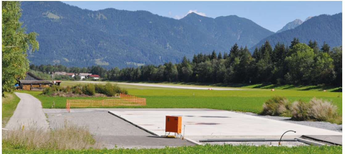
Am Rand des Höfener Flugfeldes wird der Hangar entstehen. Im Moment ist coronabedingt erst die Bodenplatte zu sehen.
