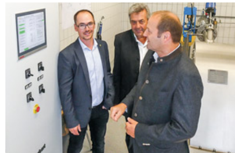
LH-Stv. Josef Geisler (r.) nahm im Beisein von VBgm. Peter Wille und Bgm. Rupert Schuchter das Trinkwasserkraftwerk in Pfunds offiziell in Betrieb.
