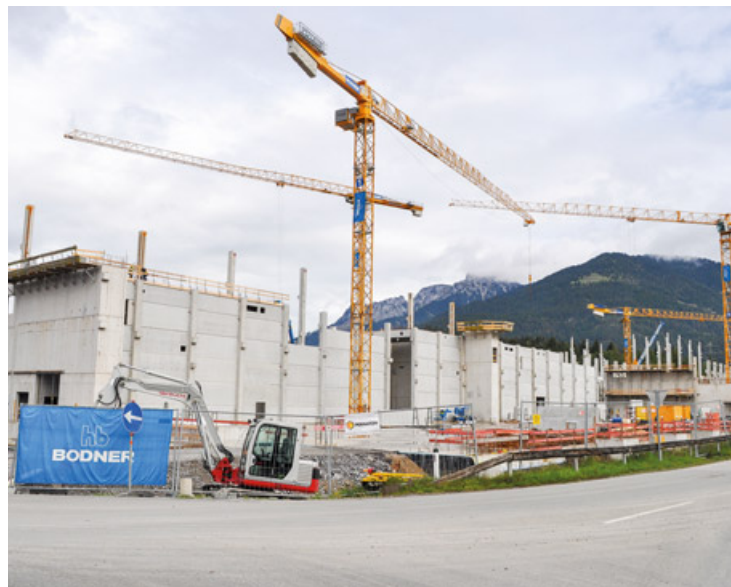
200 Meter entlang der Planseestraße wächst der neue Werksteil aus dem Boden.
