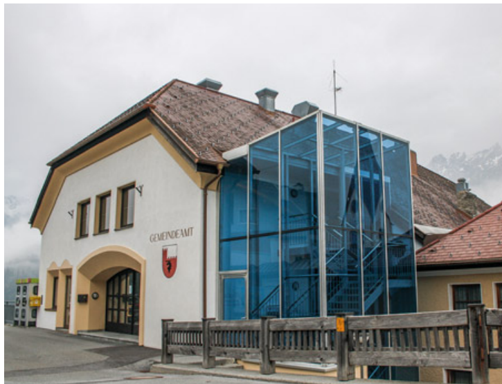
In den kommenden Jahren steht ein größeres Umbauprojekt des Gemeindehauses in Tobadill an.
