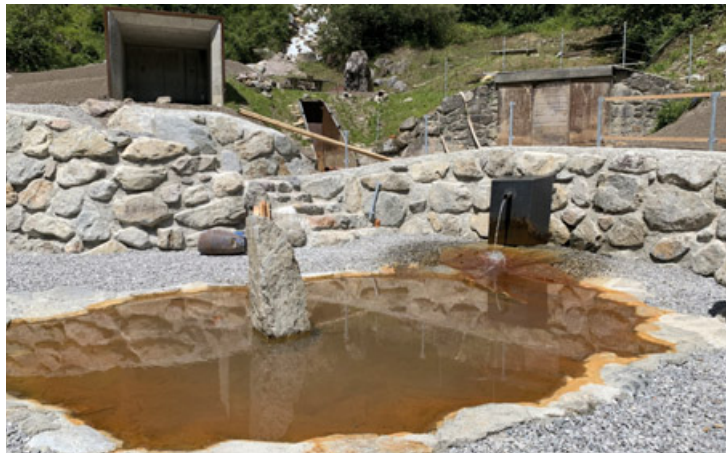
Das „Albenbad“ samt Wanderweg konnten nun wieder hergestellt werden.
