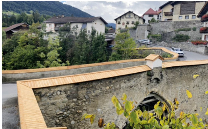
Die Römerbrücke wurde in diesem Jahr umfangreich saniert.
