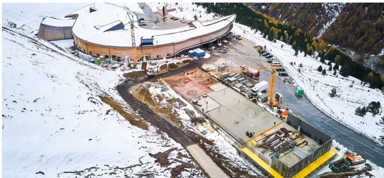
Die Erweiterung des Motorradmuseums in Hochgurgl im Baustadium.
