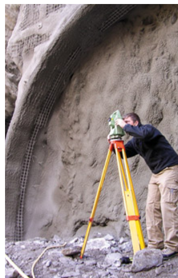
Vortriebsvermessung beim Unteren Finstermünztunnel auf der Reschenpassstraße Richtung Nauders, 2007
