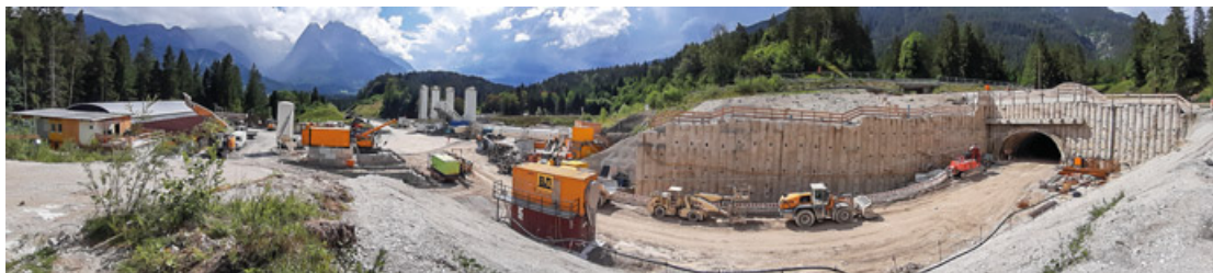
Kramertunnel, Ortsumgehung Garmisch-Partenkirchen (DE)
