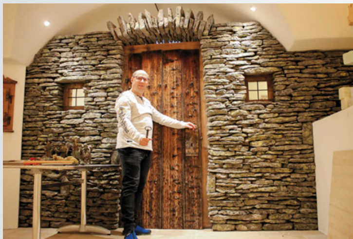
Mit dieser handgeschichteten Trockenmauer hat Harald Fiegl viel Geduld bewiesen und der alten Stadttür aus dem 17. Jahrhundert eine würdevolle Fassung verliehen.
