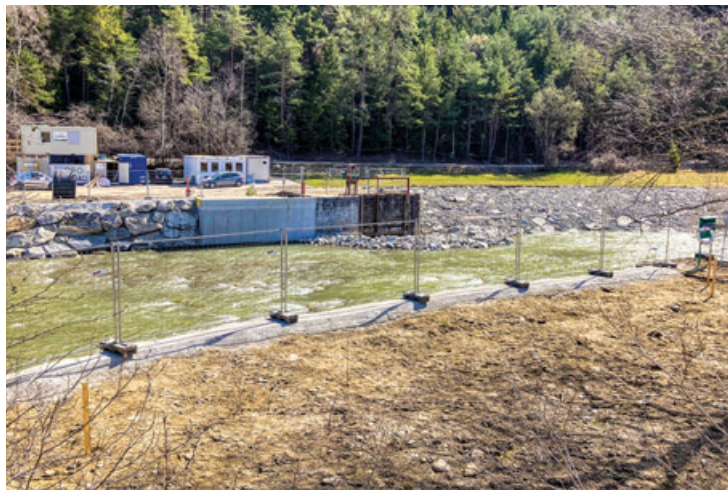
Die Arbeiten am Brunauer Wehr stehen vor dem Abschluss.
