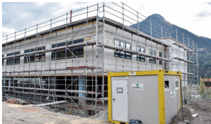
Die Sanierung der Volksschule Imst-Unterstadt kostet knapp mehr als fünf Millionen Euro und kommt de facto einem Neubau gleich.
