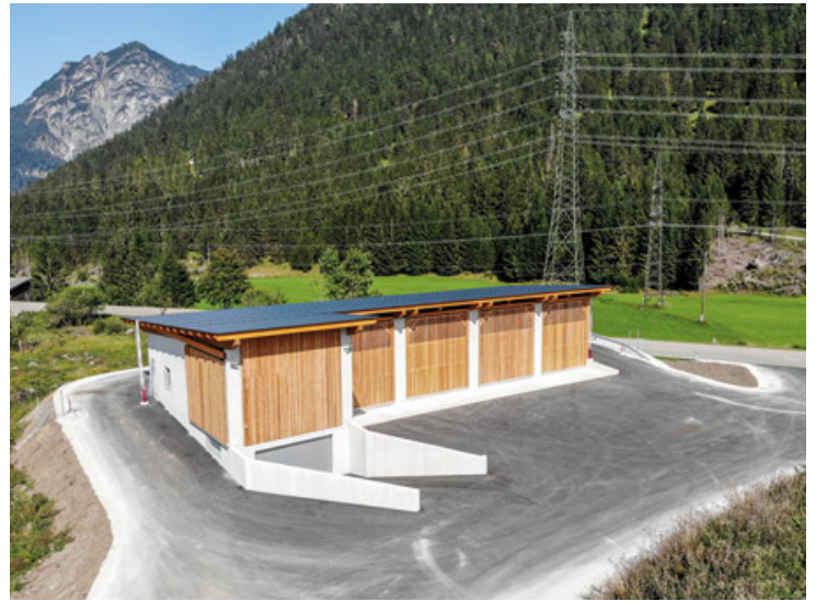
Der Wertstoffhof der Gemeinde Heiterwang wurde neu errichtet.
