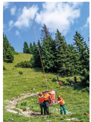
Mit Hubschrauber und Betonkübel wurde der benötigte Schotter angeliefert.
