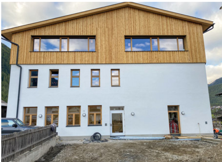
Volksschule und Kindergarten Unterried konnten bereits im Herbst von den Kindern bezogen werden.
