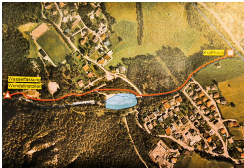
Über 920 Meter Druckrohrleitung werden ab Nikolaus 190 Liter pro Sekunde Wasser 103 Kilowatt Strom erzeugen.
