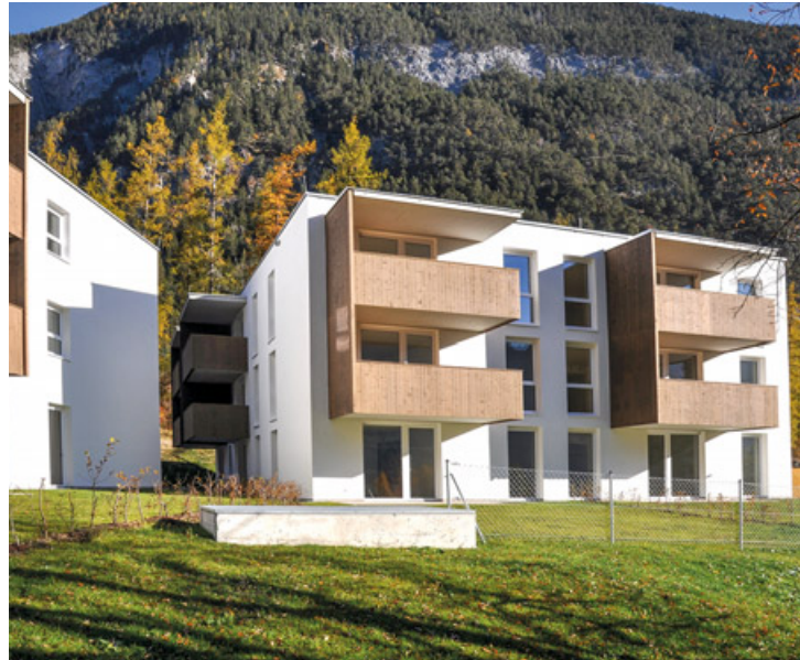
Die ersten beiden Baukörper der GHS-Wohnanlage sind fertiggestellt, die Wohnungen werden übergeben.
