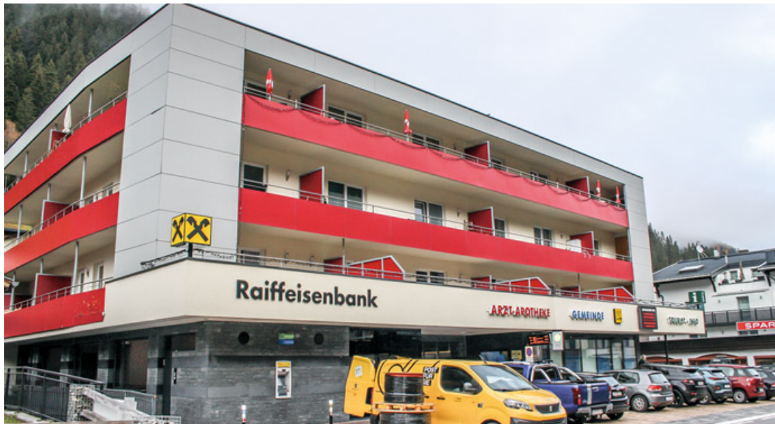
Beim Gemeindehaus könnte ein zweiter Bauabschnitt mit 20 zusätzlichen Wohnungen umgesetzt werden.
