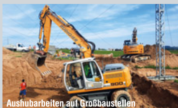
Aushubarbeiten auf Großbaustellen
