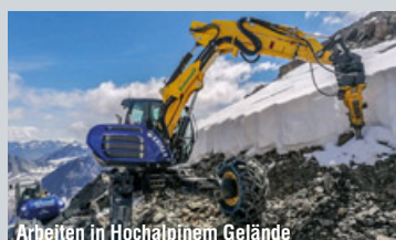
Arbeiten in Hochalpinem Gelände
