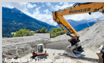
Aushub für ein Einfamilienhaus
