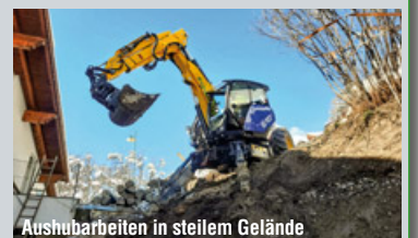
Aushubarbeiten in steilem Gelände
