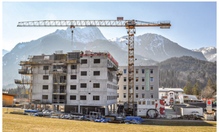
In unmittelbarer Nähe zum Innovationszentrum entsteht nun das „Gesundheitszentrum Pflach“.
