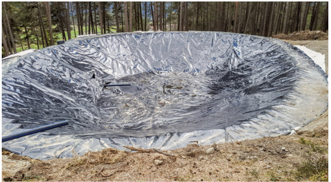
Für den Speicherteich wird derzeit die Hauptleitung gelegt. Die Grube ist bereits mit Folie ausgelegt, jetzt fehlt noch die Begrünung der Böschung sowie der Kies.
